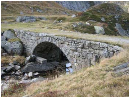
Abb. 1: Bogenbrücke „Ponte di Cima“
